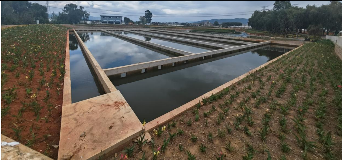
已实施沉砂池（2023年4月实施）
