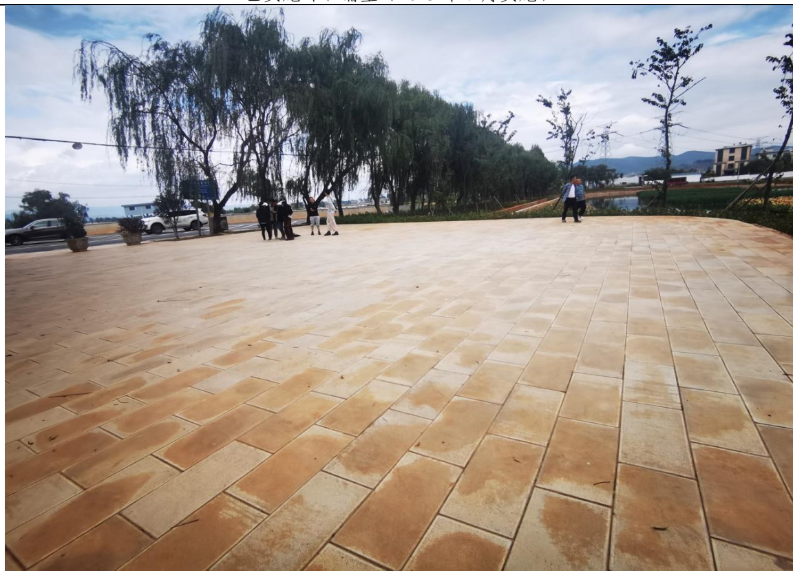
已实施透水砖铺装（2023年7月实施）
