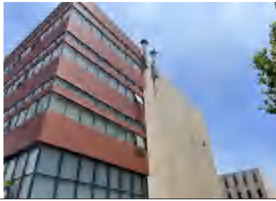
实验室外围及油烟排气管道
